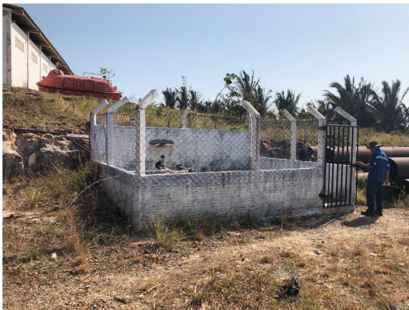
Figura 6: Área do Poço envolto de uma proteção de alvenaria conforme a Norma NBR 12212/17
